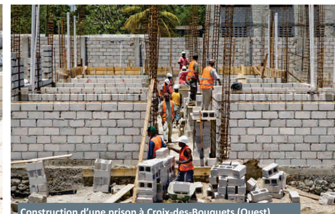
Construction d'une prison à Croix-des-Bouquets (Ouest)
