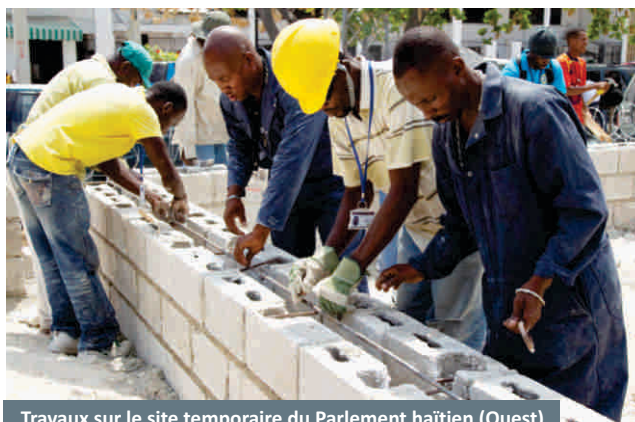
Travaux sur le site temporaire du Parlement haïtien (Ouest)
