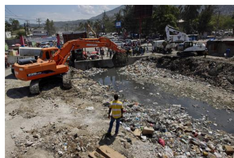
Source : photo MINUSTAH - Curage du canal
